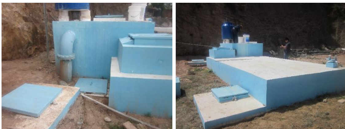
Fotos de Tanque de llegada y tanque de cloración
