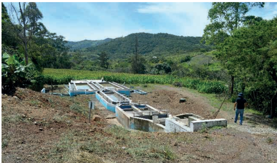
Planta tratamientos aguas servidas Catacocha.
