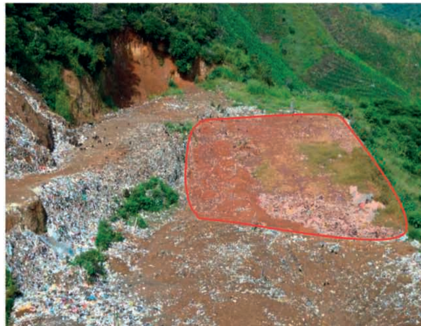
Zona inundada en relleno. Atascamiento de maquinaria
