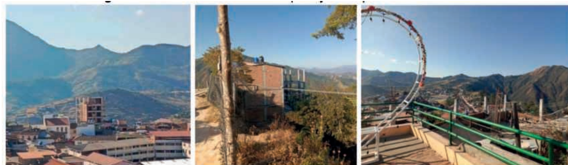
Figura 40. Destrucción de visuales paisajísticas por edificaciones en altura.
