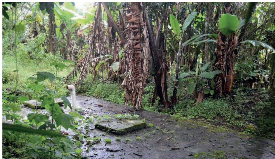
Planta tratamientos aguas servidas Lauro Guerrero.
