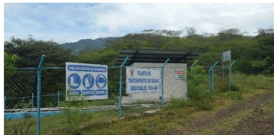
Planta tratamientos aguas servidas Yamana.
